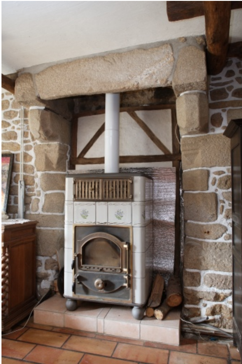
La cheminée du logis ouest.
