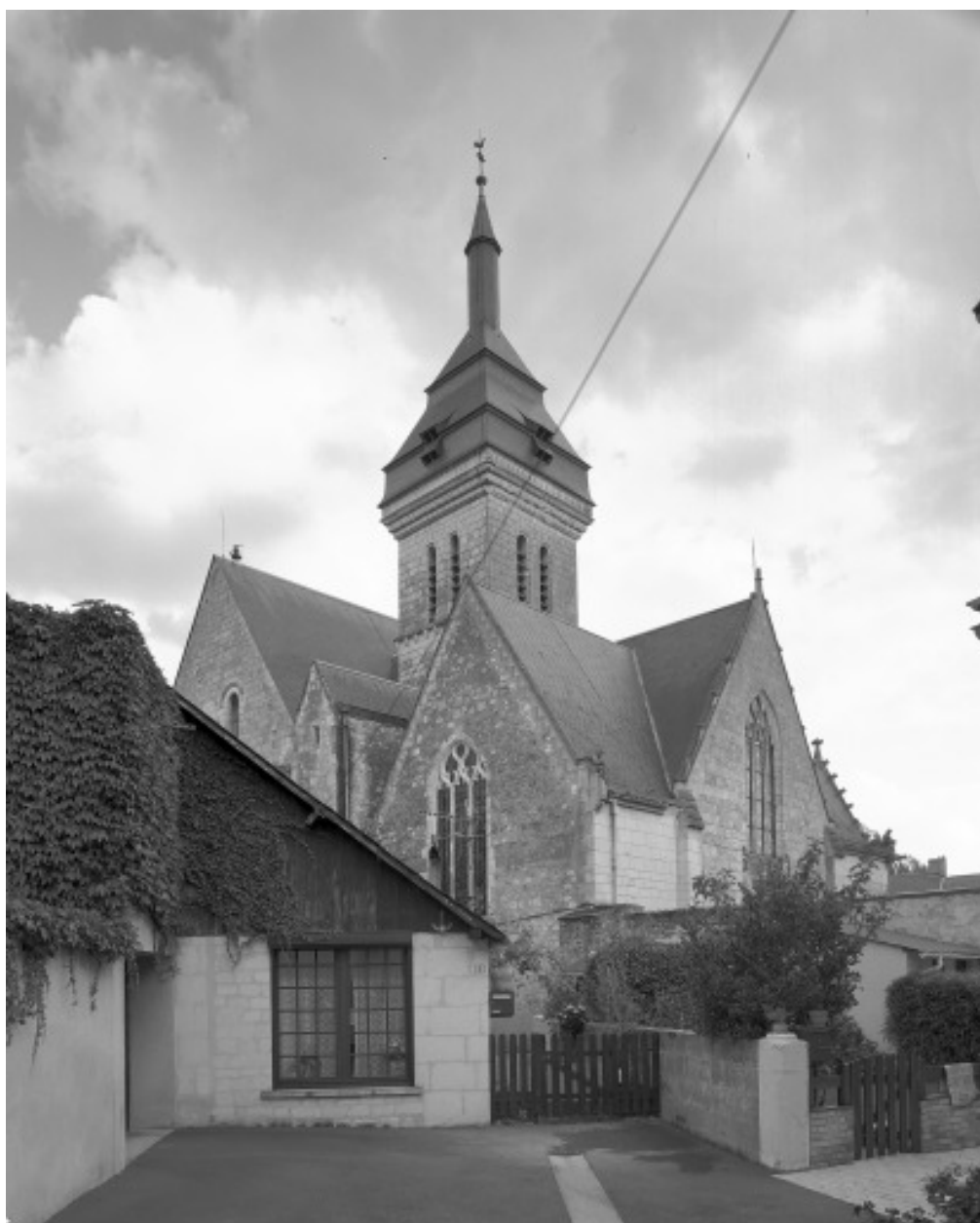
Vue de volume prise du Nord-Ouest.
