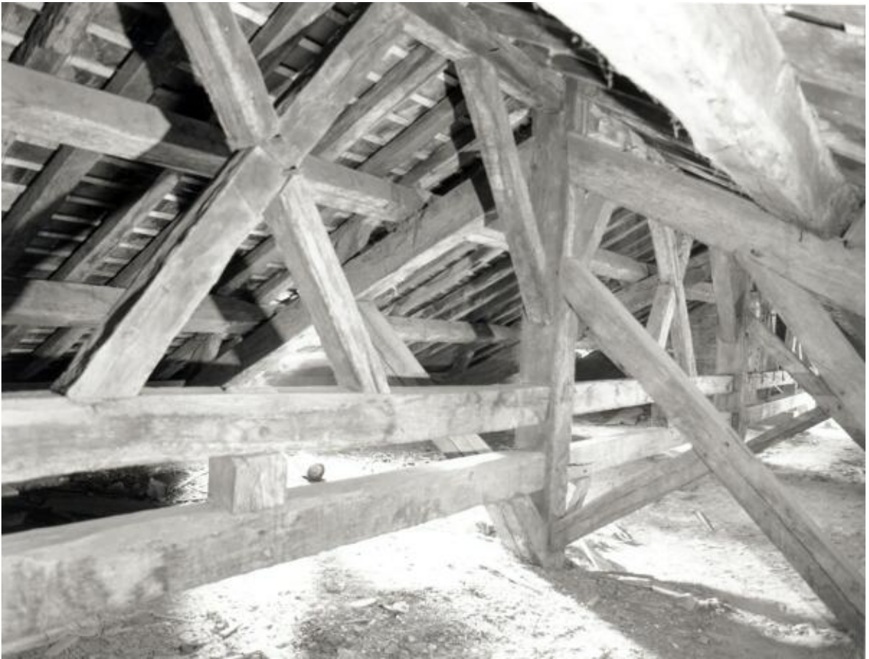
Aile est du cloître : charpente, vue en axe longitudinal nord-sud.
