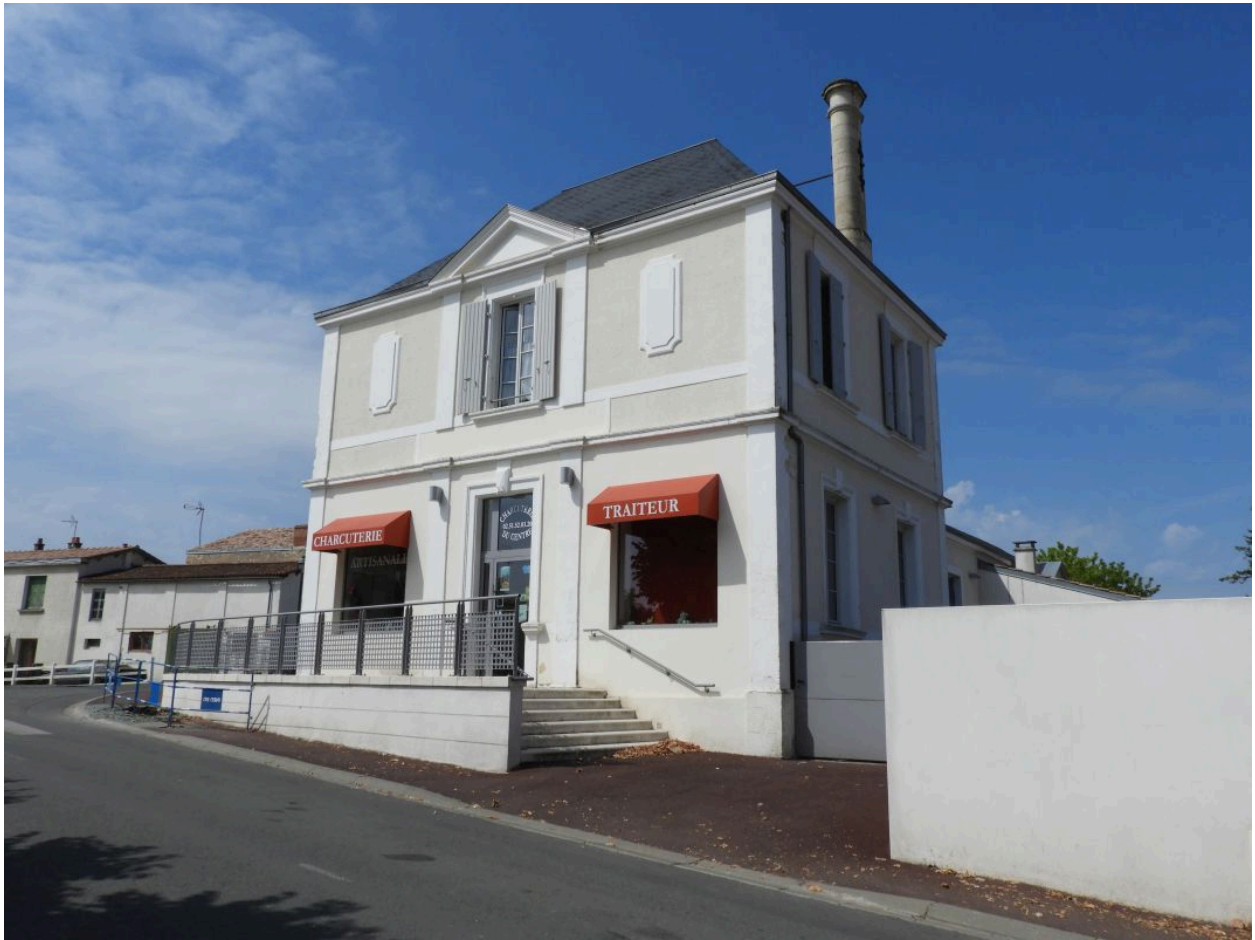
La boucherie, ancienne mairie puis bureau de poste, vue depuis le nord-est.
