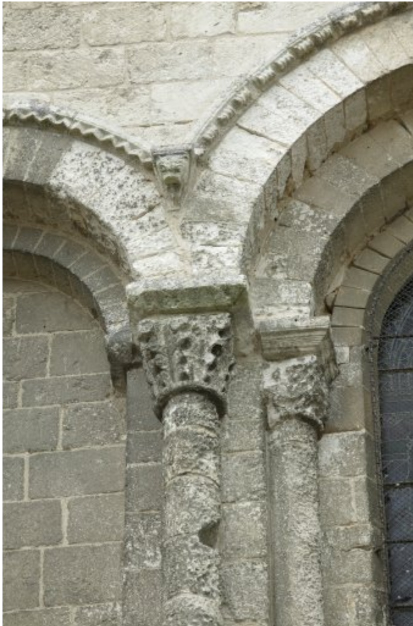
Façade du bras nord du transept : détail de la partie centrale du niveau supérieur.
