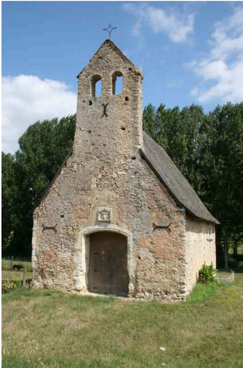
La chapelle : façade occidentale.
