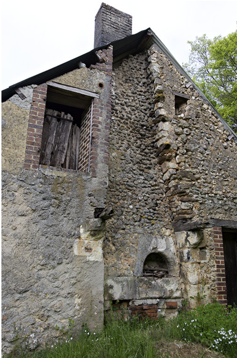
Maison, mur-pignon est : vestiges d'une cheminée avec four à pain.
