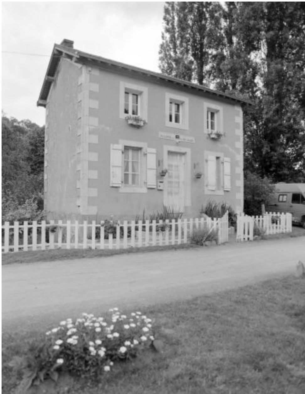
La maison éclusière.
