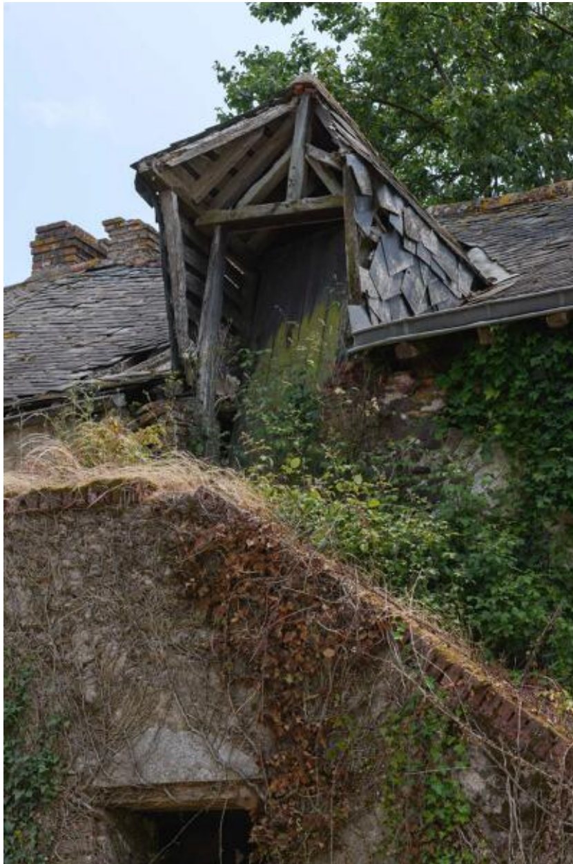
Détail de l'accès au comble à surcroît d'un des logis de la ferme du Theil.
