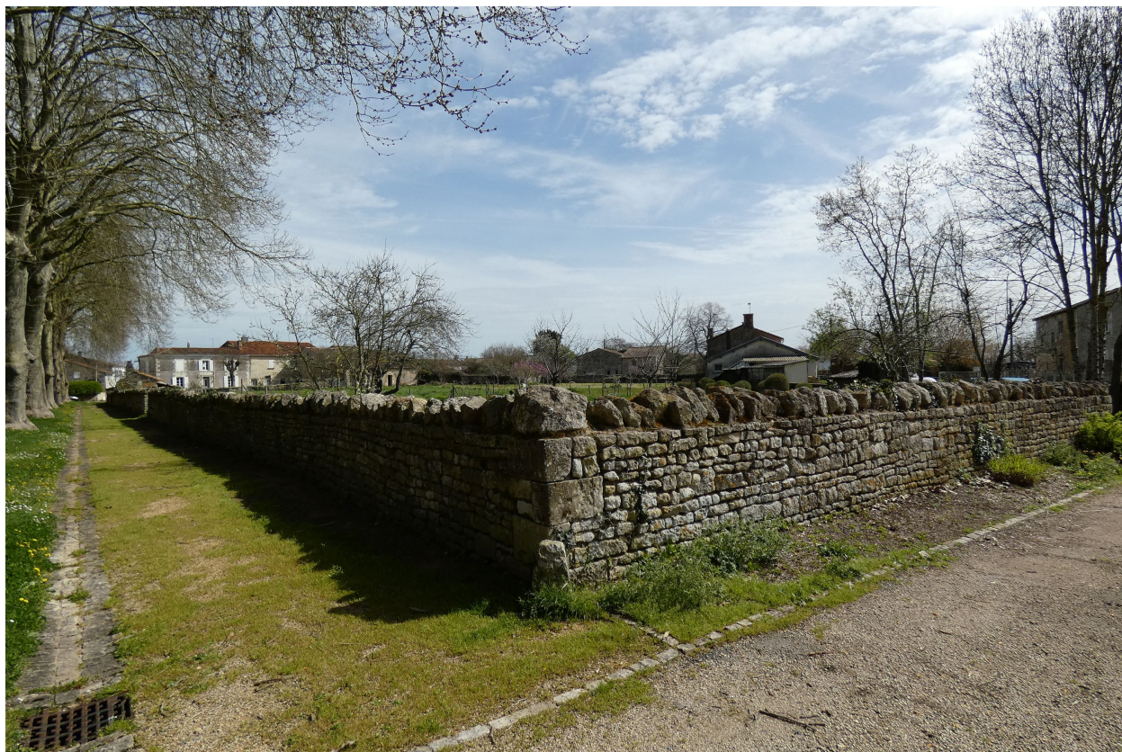
Le mur vu depuis l'ouest.
