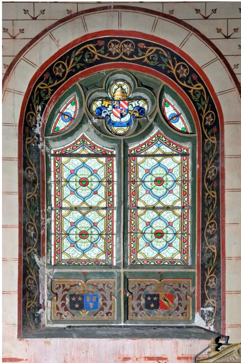
Fenêtre nord du chœur.
