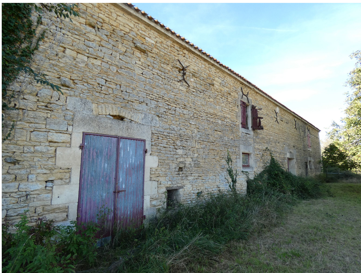
La grange-étable vue depuis le nord-est.
