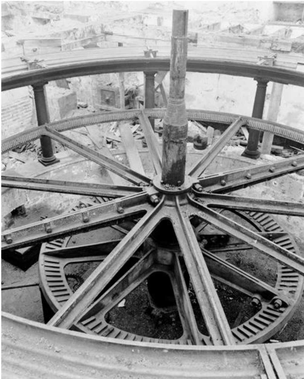
Bâtiment A ; La cage et l'axe de la turbine depuis le nord.
