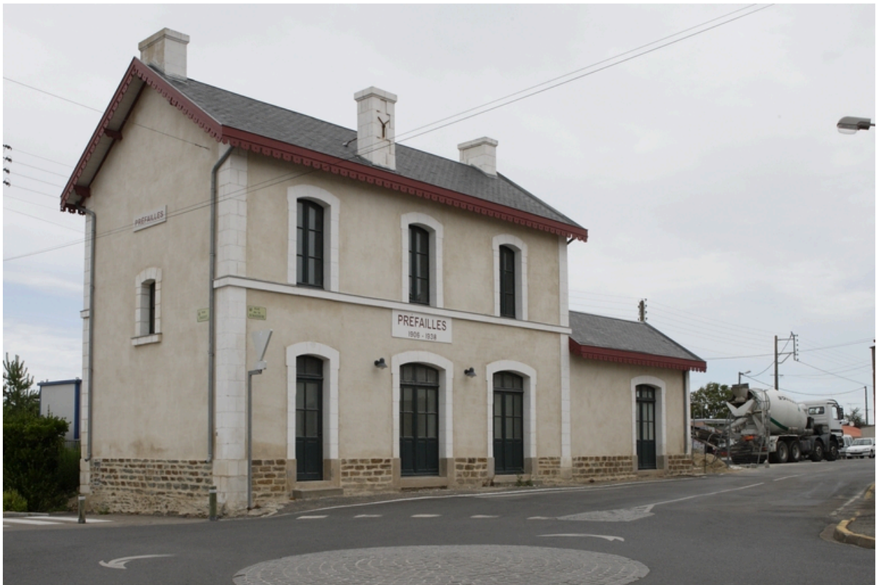
Vue d'ensemble prise du sud-est.
