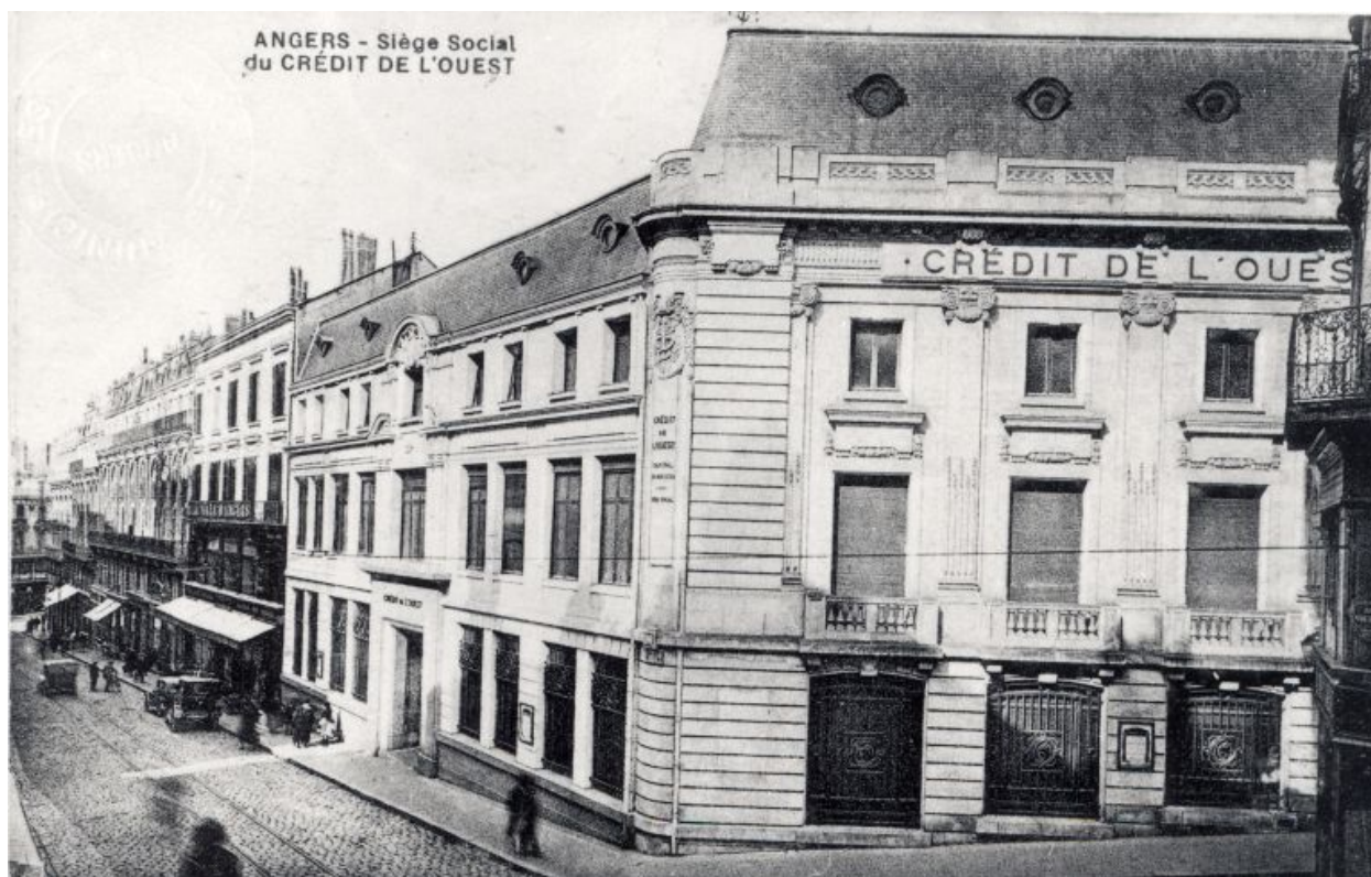
Angers, siège social du Crédit de l'ouest, façades sur les rues Voltaire et Corneille, carte postale, début 20e siècle.
