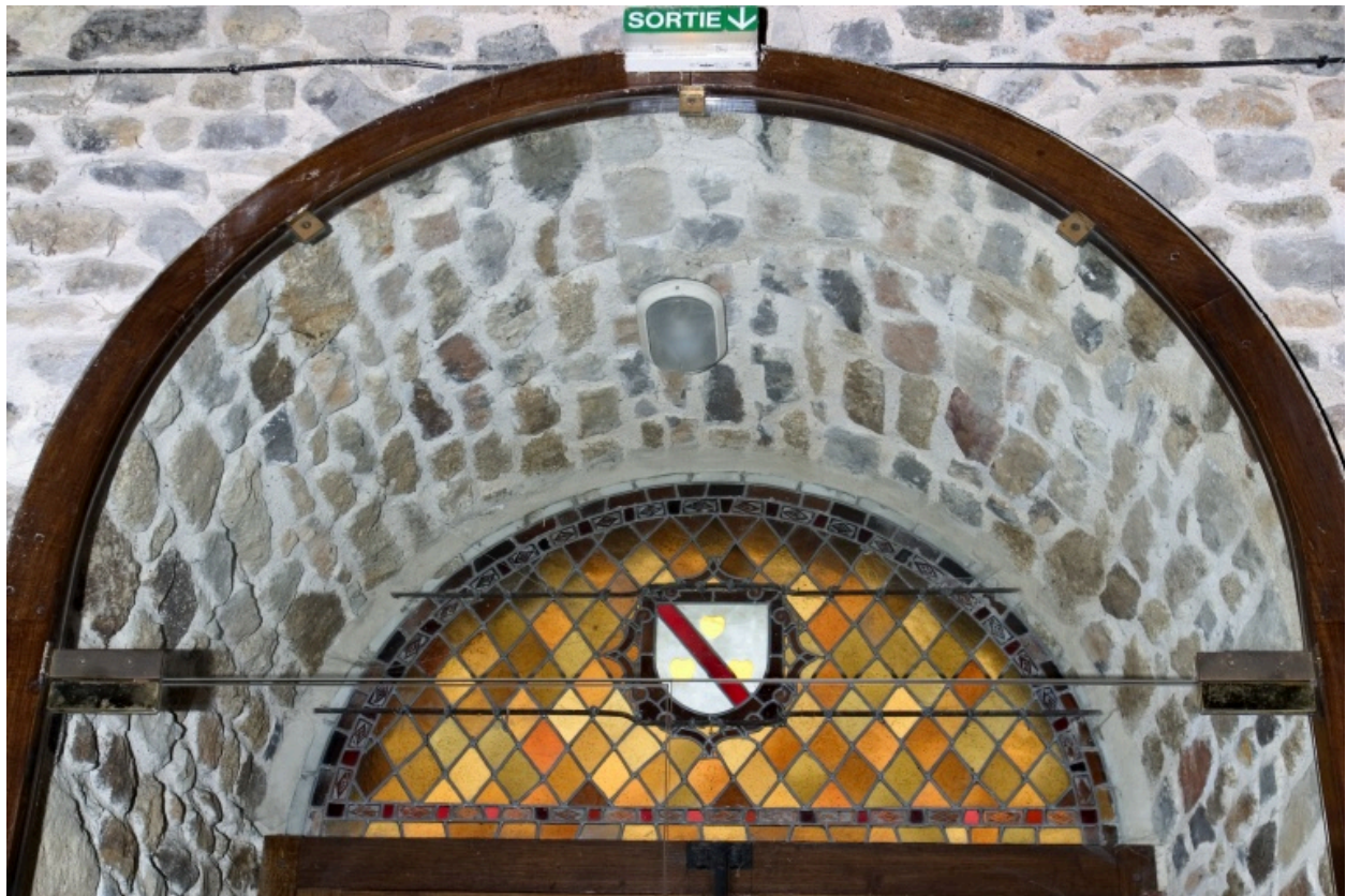
Vue générale de la verrière de la porte.
