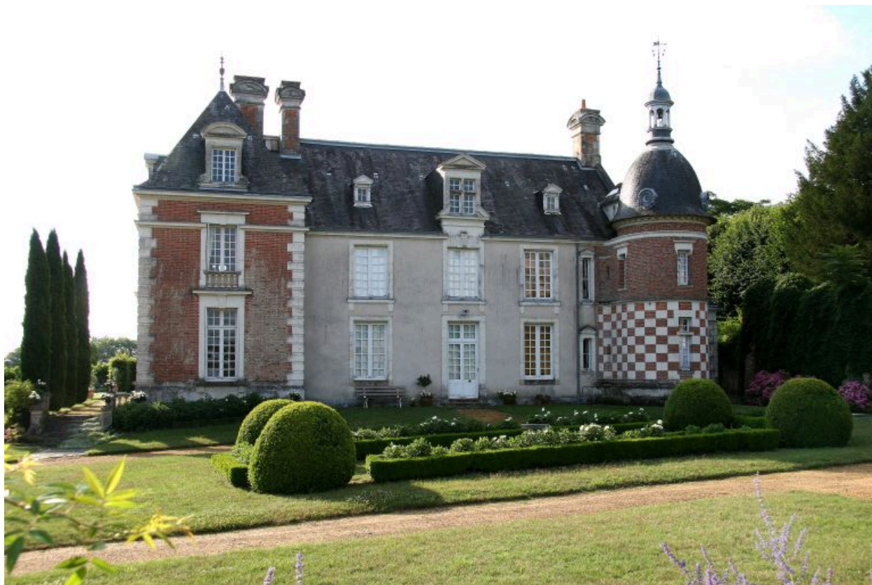
Le logis : façade antérieure.
