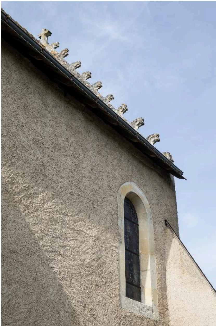
Nef, mur nord : baie (7).
