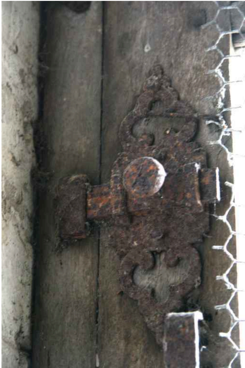
1er étage, garde-robe centrale, détail : targette.
