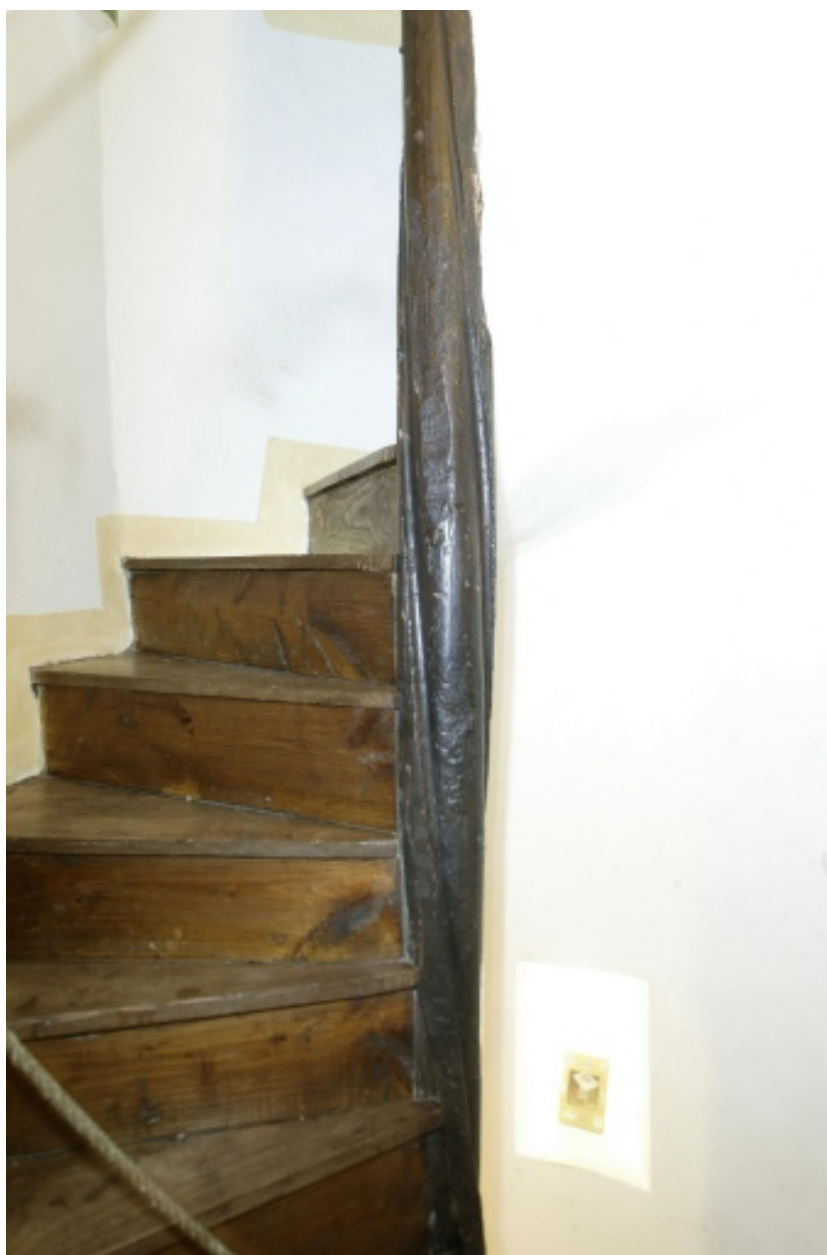
Escalier vu depuis le rez-de-chaussée.
