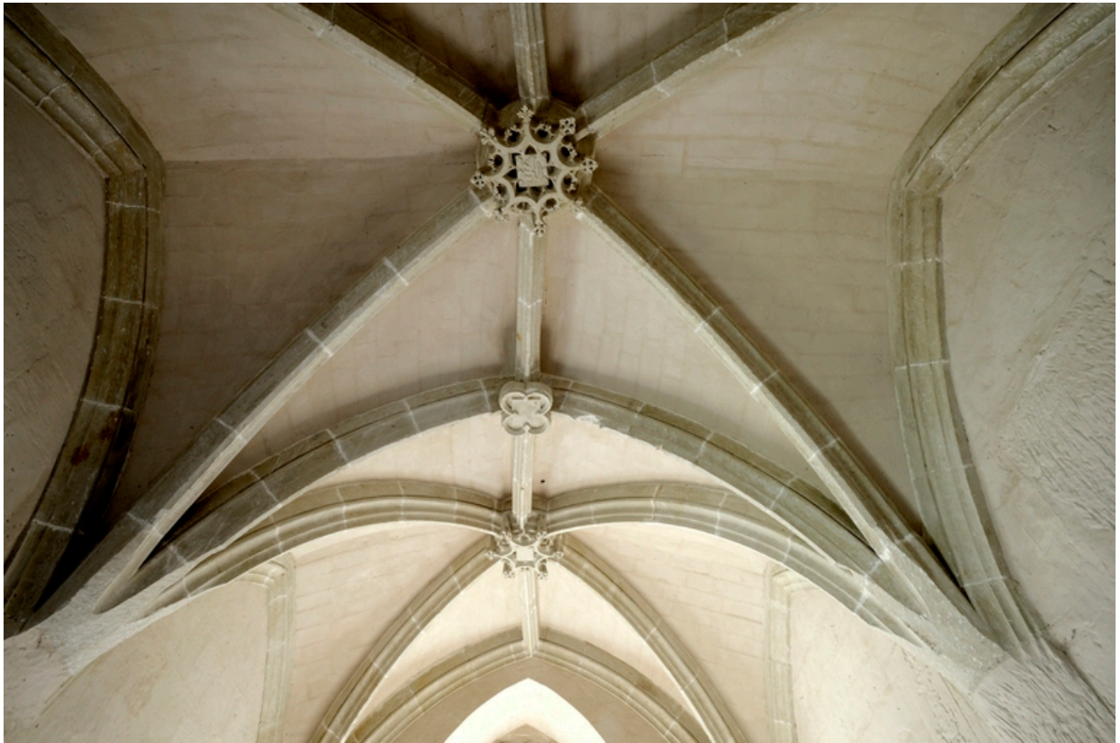
Ancienne chapelle nord (fin XVe siècle), étage. Voûtes.
