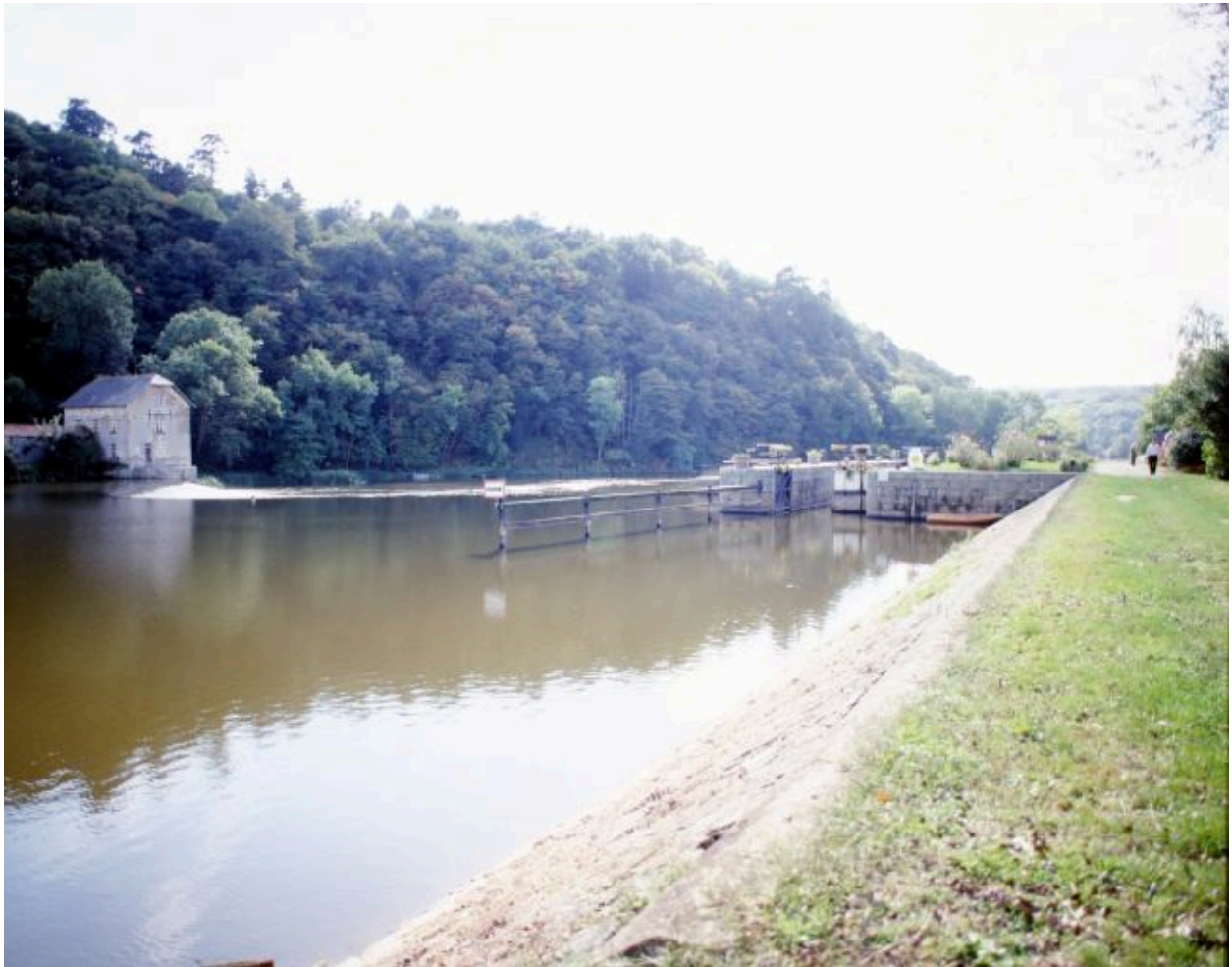
Vue d'ensemble depuis le chemin de halage, rive droite, en amont : moulin, barrage, moulin.
