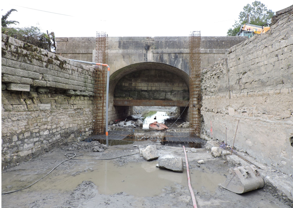
Août 2020 : l'aqueduc dégagé vu depuis l'amont, avant restauration.
