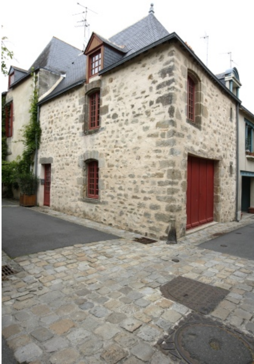
Vue générale vers le Nord-Est.
