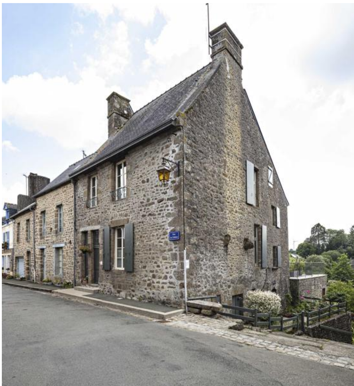
Maisons, 16-20 rue du Château.
