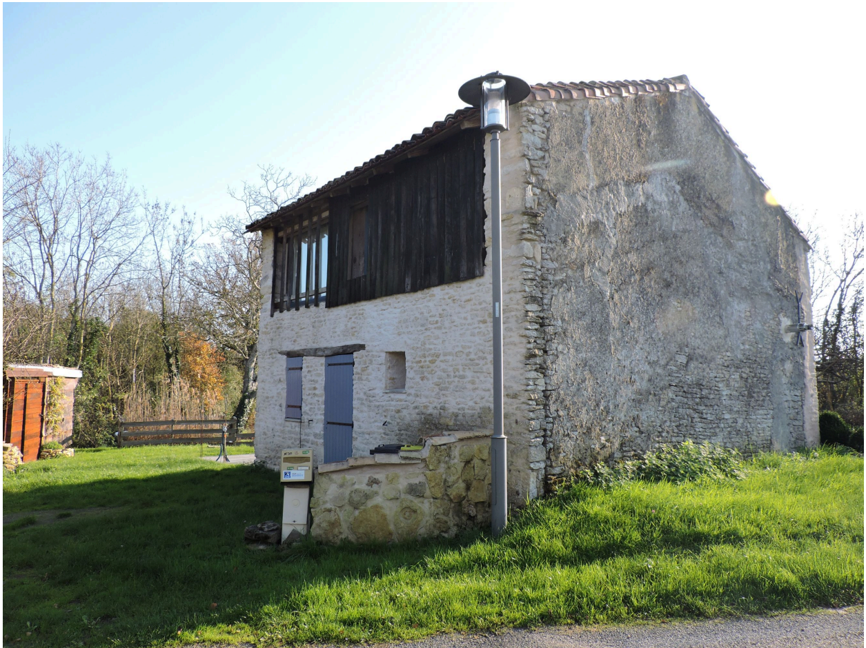
Le logis et les dépendances à l'arrière vus depuis le nord.
