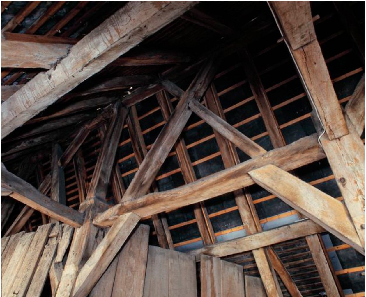
Comble. Charpente, détail du contreventement, à faîtage, sous-faîtage, liens en croix de Saint-André et aisseliers.
