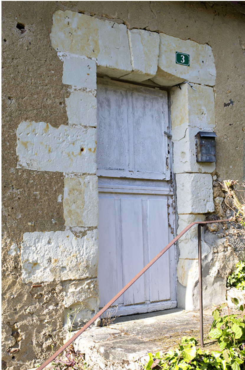
Façade sud, détail : la porte (côté droit).
