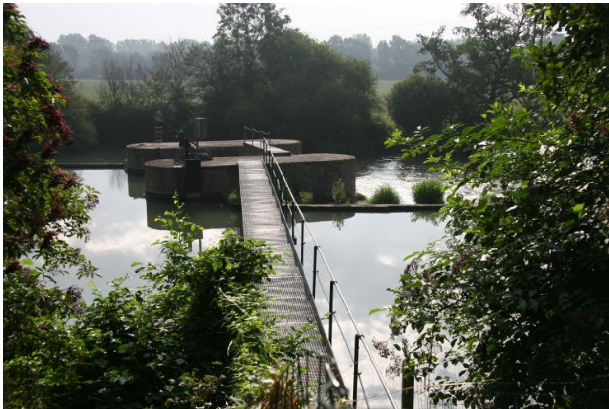
Barrage à aiguille sur le Loir et chaussée du moulin de Cherré.
