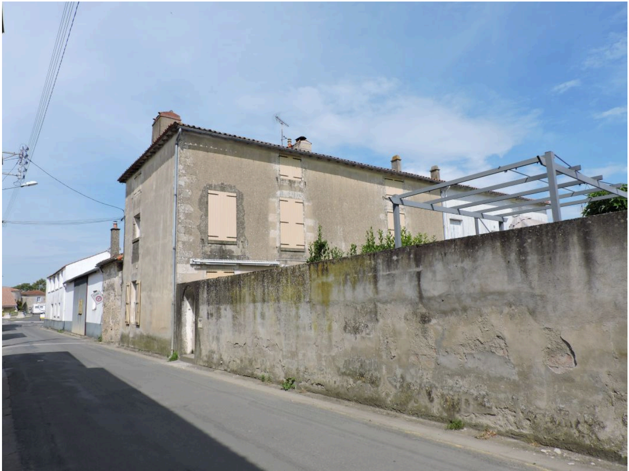
Le logis vu depuis le sud-ouest.
