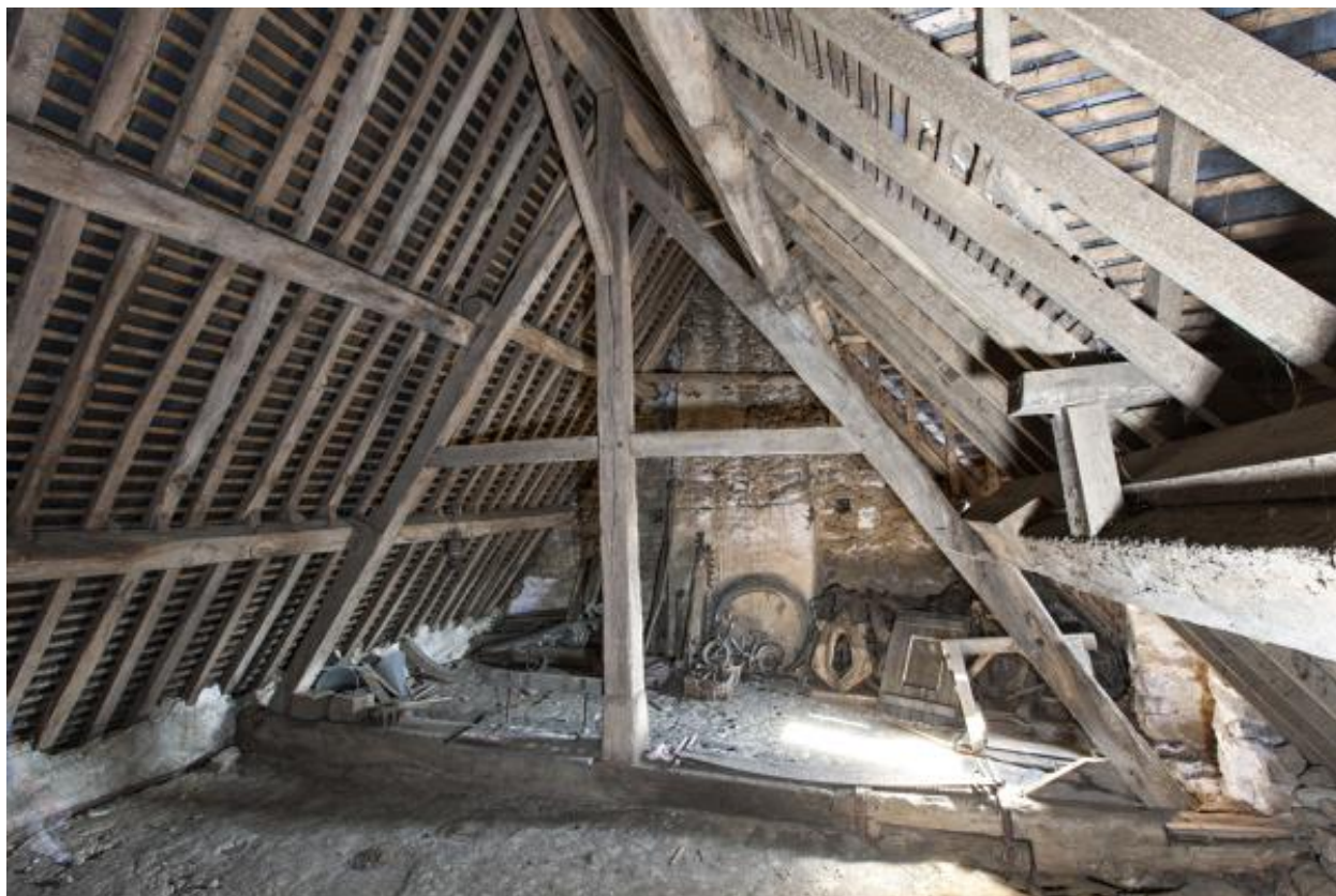
Charpente de la demeure de Bignon.
