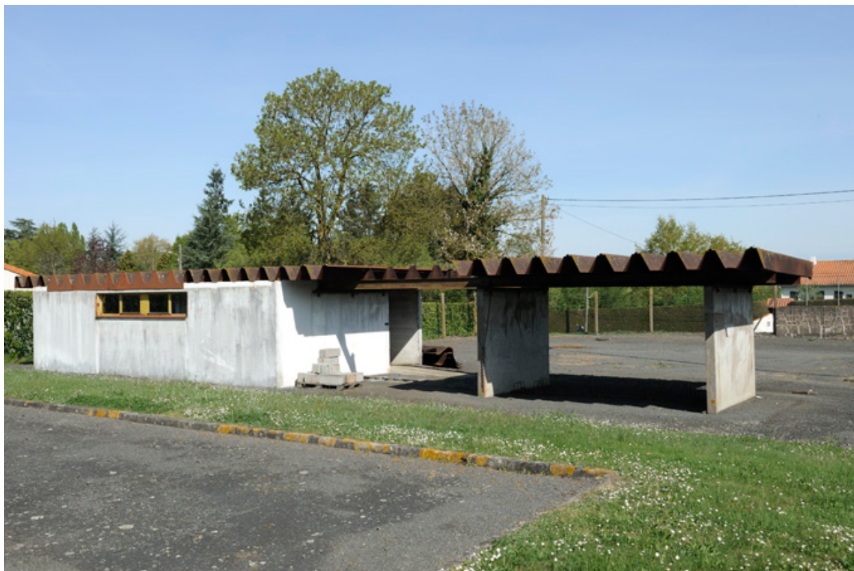
Usine SACAIR : garage à vélo.
