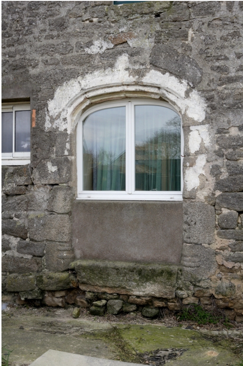
Détail de la porte de la façade nord.
