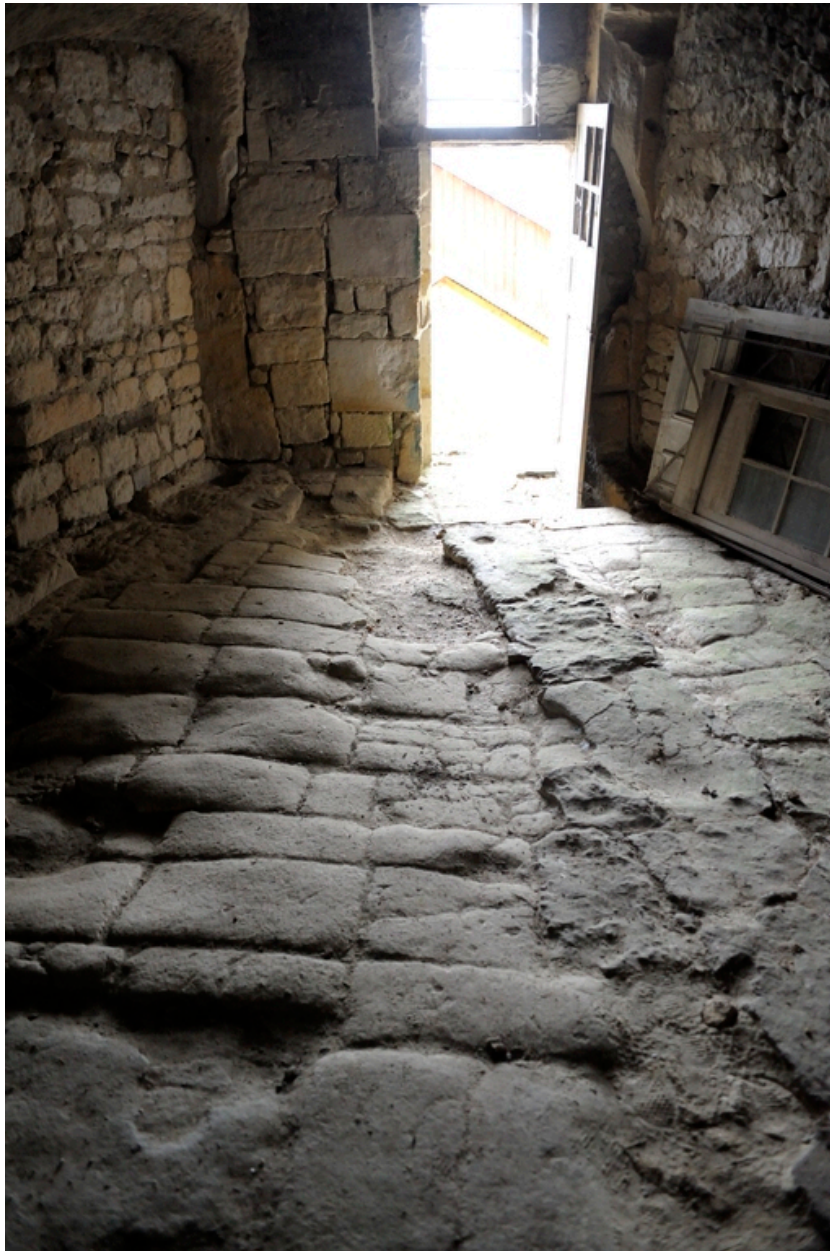
Salle centrale de l'abri troglodytique. Pavement en dalles rectangulaires de tuffeau.
