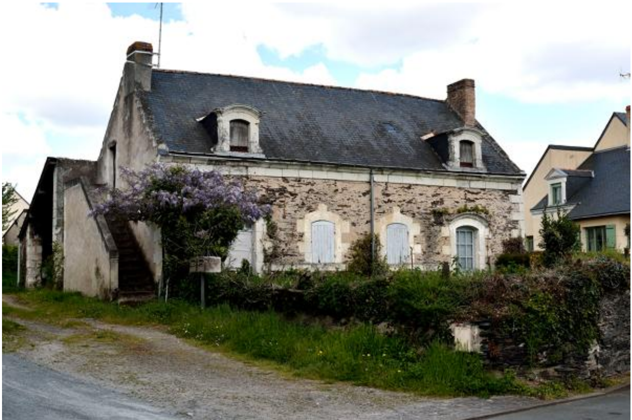
Vue du 24 route de Port-Thibault.
