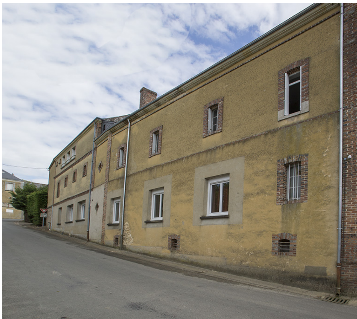
Bâtiments A et B, façades sur la rue du Tusson.
