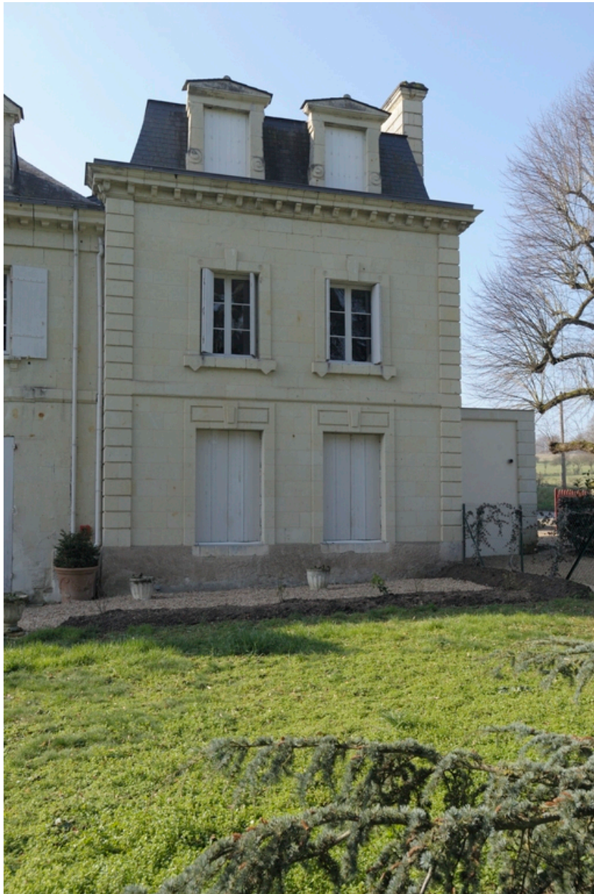
Logis. Pavillon ouest, façade nord.
