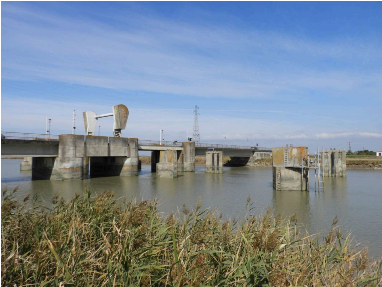
Le pont vu depuis la rive gauche du fleuve, côté amont, au sud-est.
