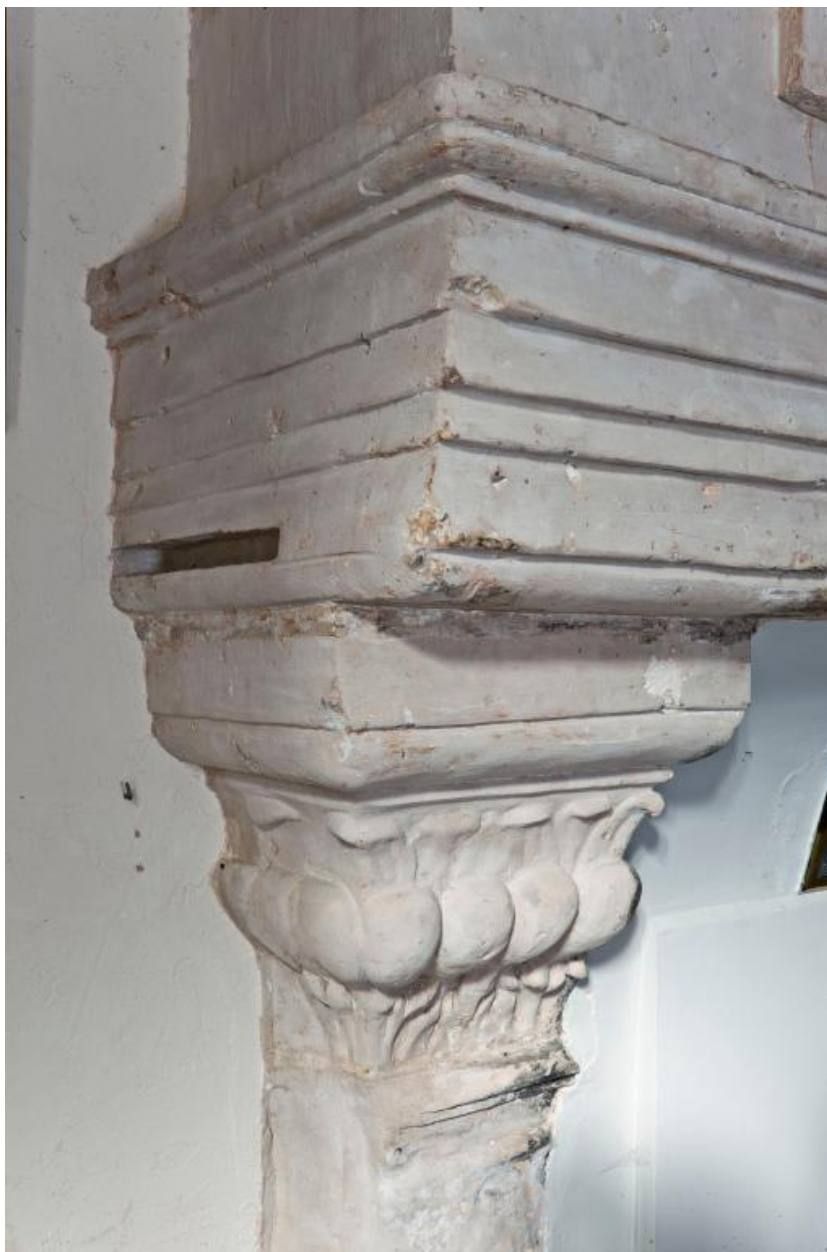
Maison, rez-de-chaussée, pièce à feu ouest : détail du linteau et corbeau gauche.
