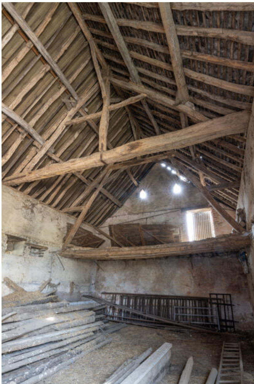
Grange-étable dissociée : charpente.
