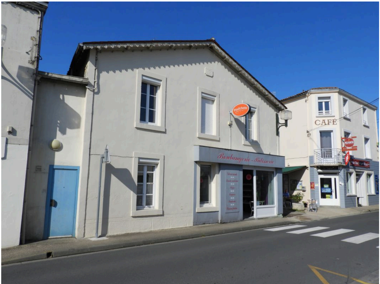
La boulangerie vue depuis le nord-est.
