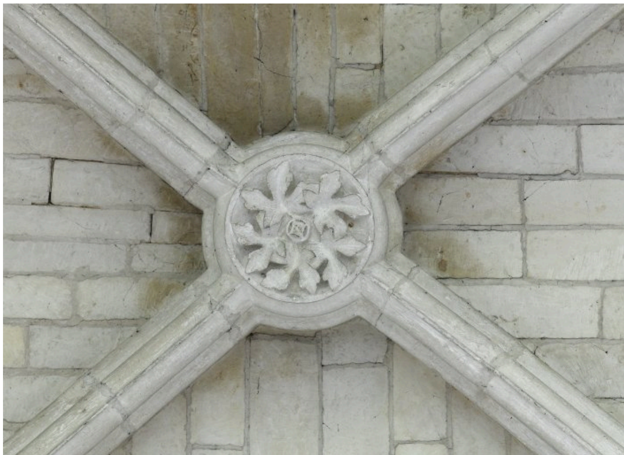
Bas-côté sud de la nef : clef de voûte de la troisième travée.
