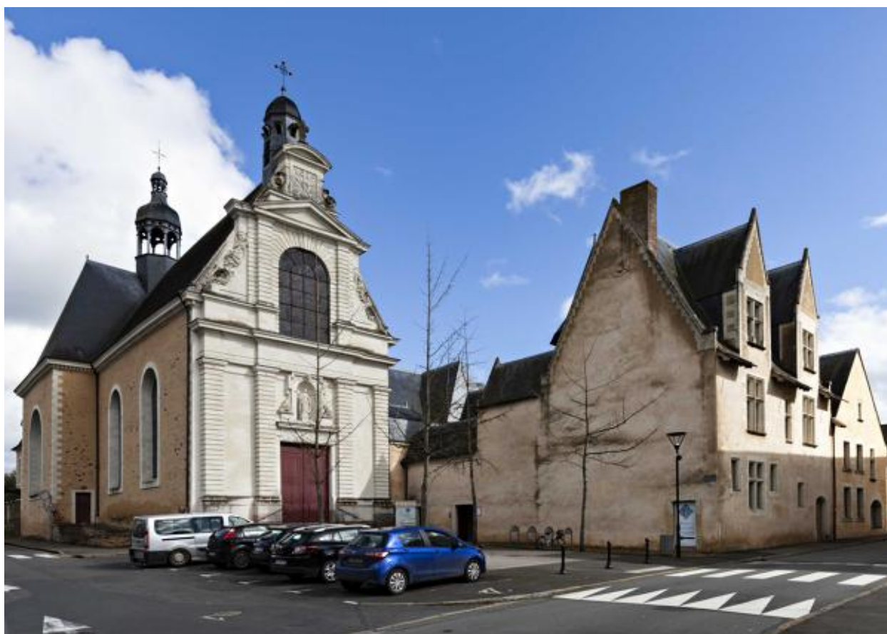
Vue de la façade de la chapelle des Ursulines et du "logis XVe" du couvent des Ursulines de Château-Gontier.
