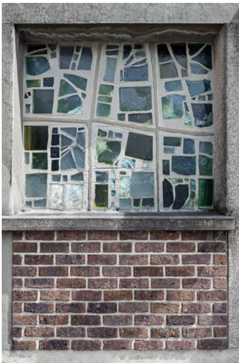
Vue d'une ouverture extérieure de la sacristie en dalle de verre.
