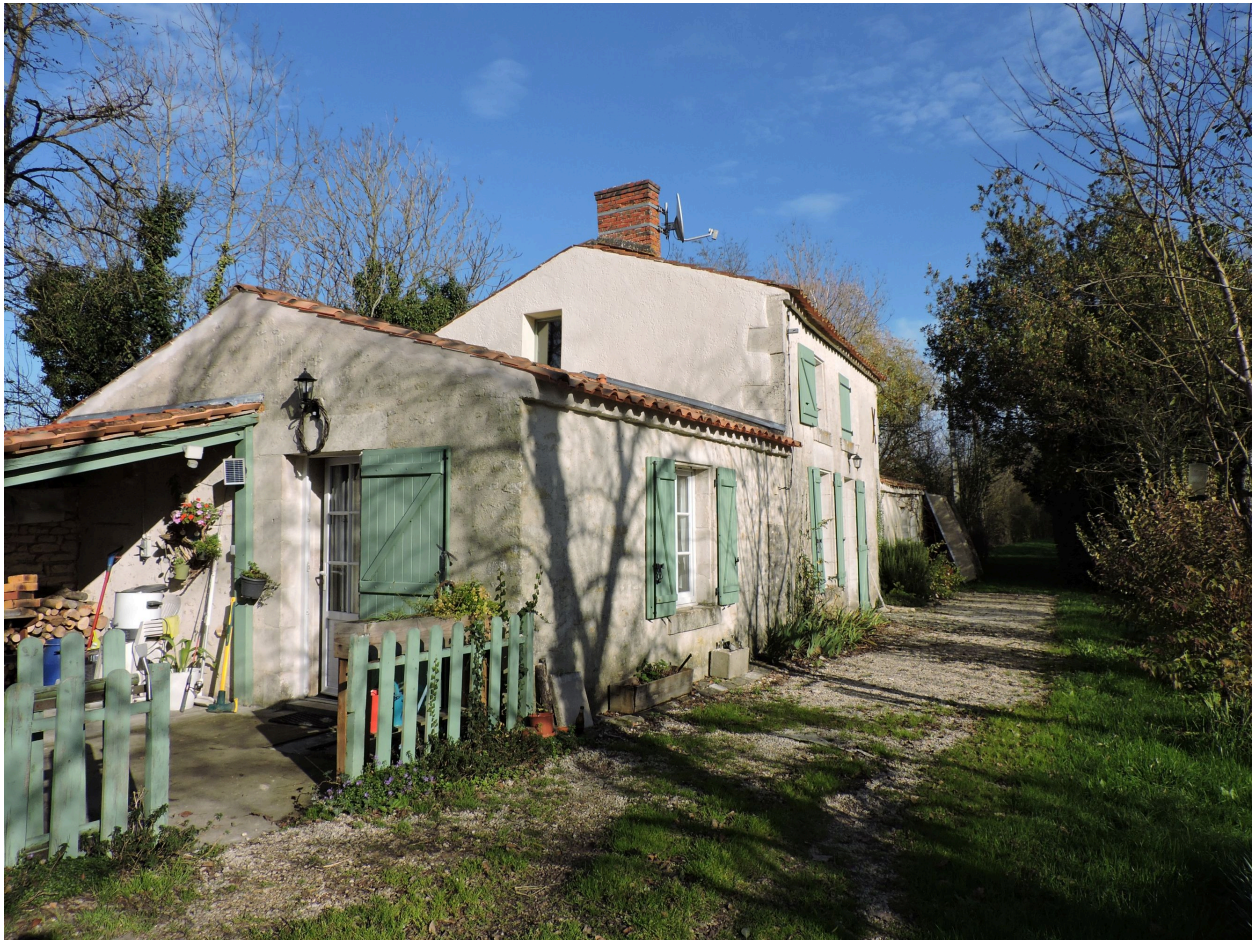
La hutte vue depuis l'ouest.
