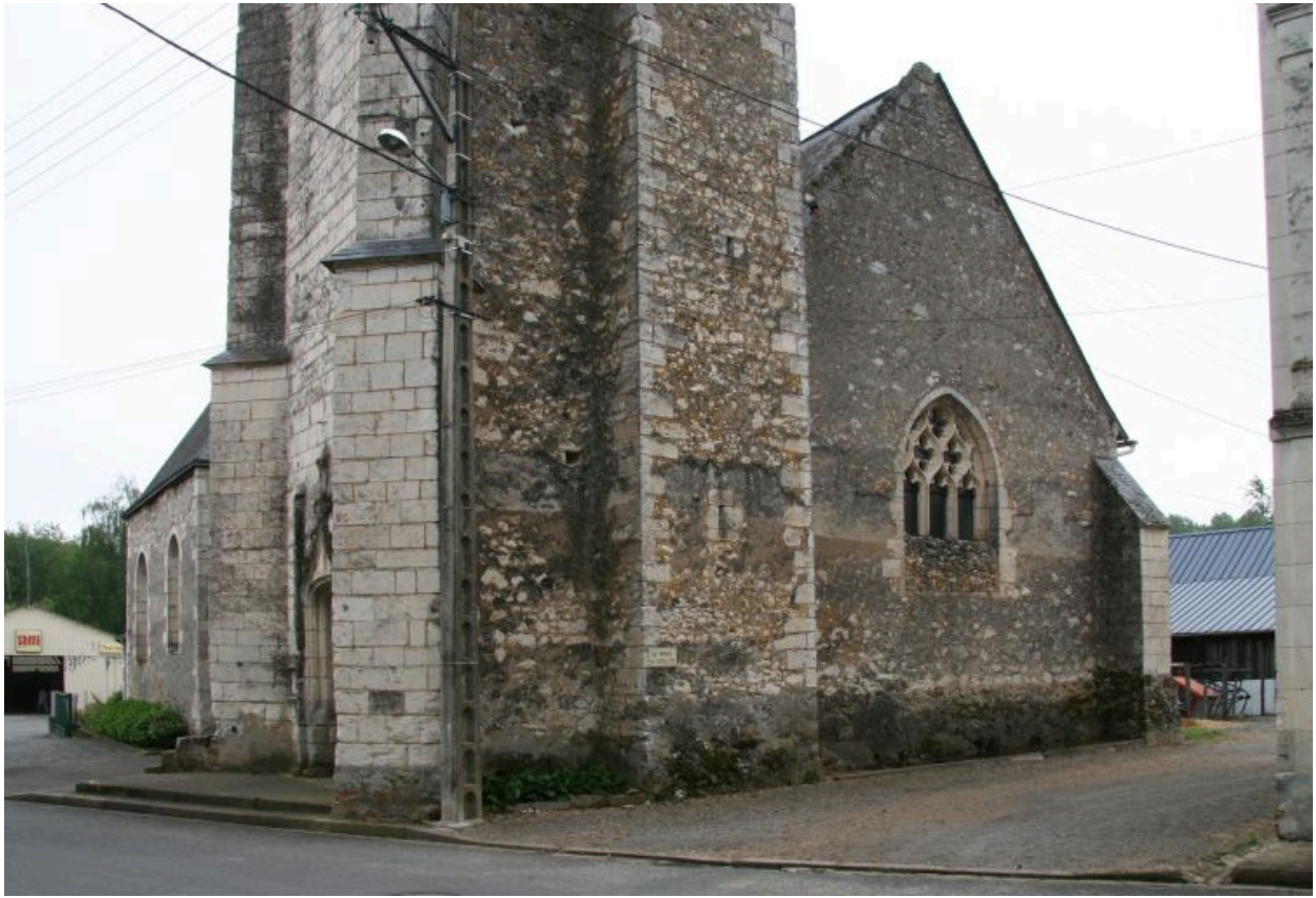
Façade occidentale de la nef sans portail mais flanquée d'un clocher-porche.
