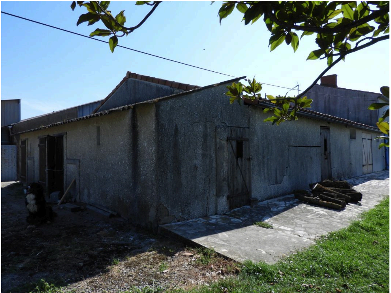
L'ancien toit à porcs dans le prolongement ouest du logis.
