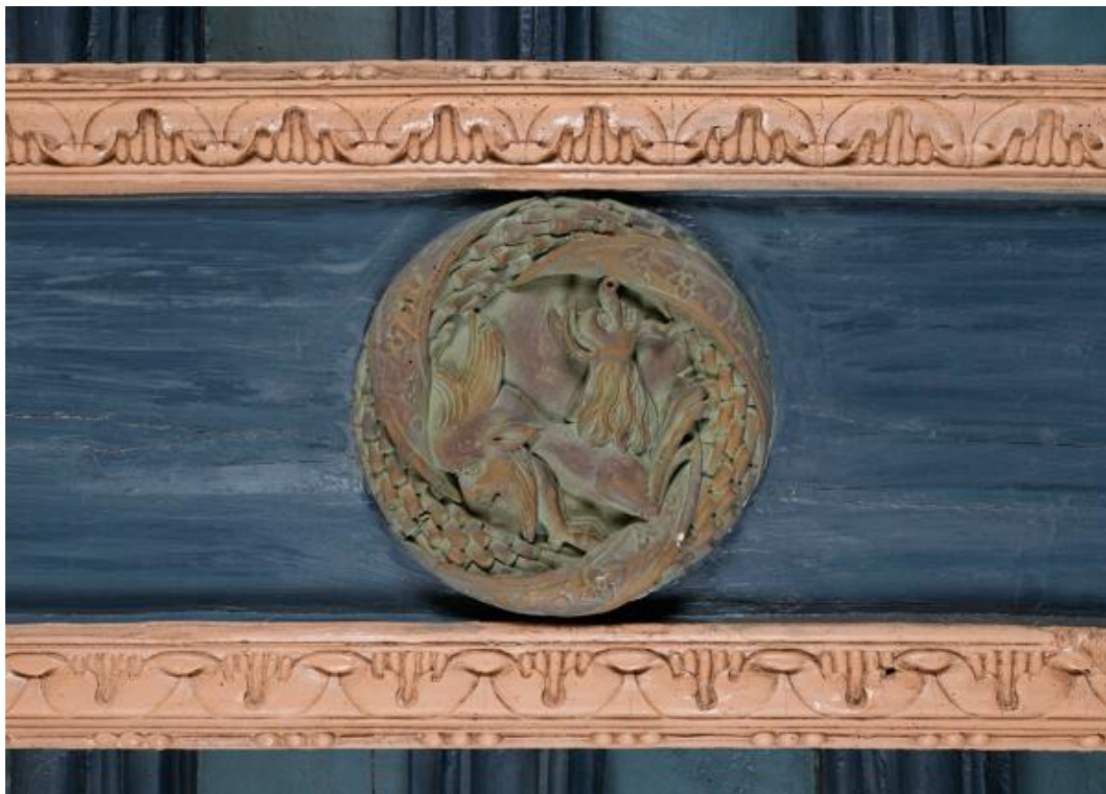
Grande salle. Plafond. Sous-face de la poutre sud. Détail du huitième médaillon en partant de la gauche.
