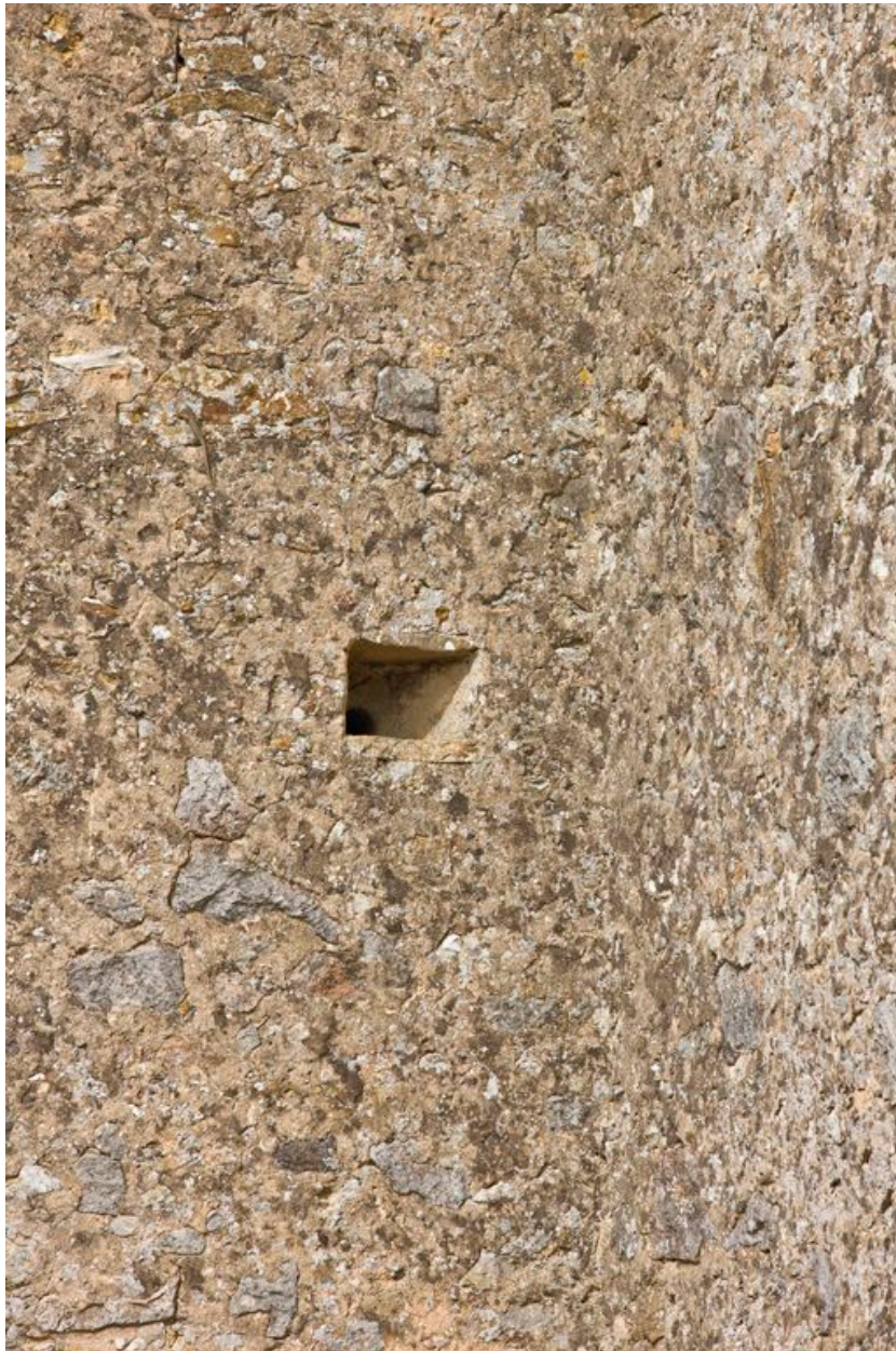
Meurtrière sud de l'étage carré de la tour.
