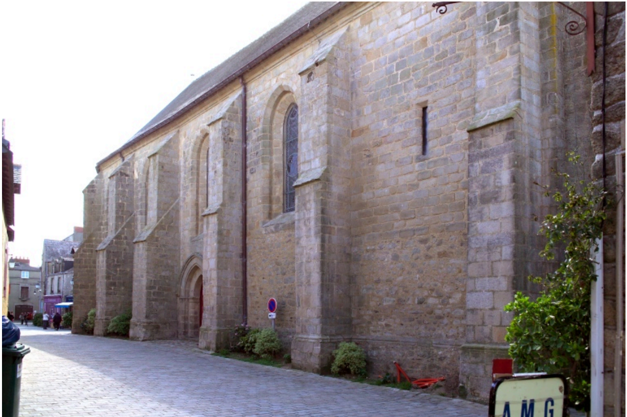
Vue du mur nord depuis le nord-ouest.
